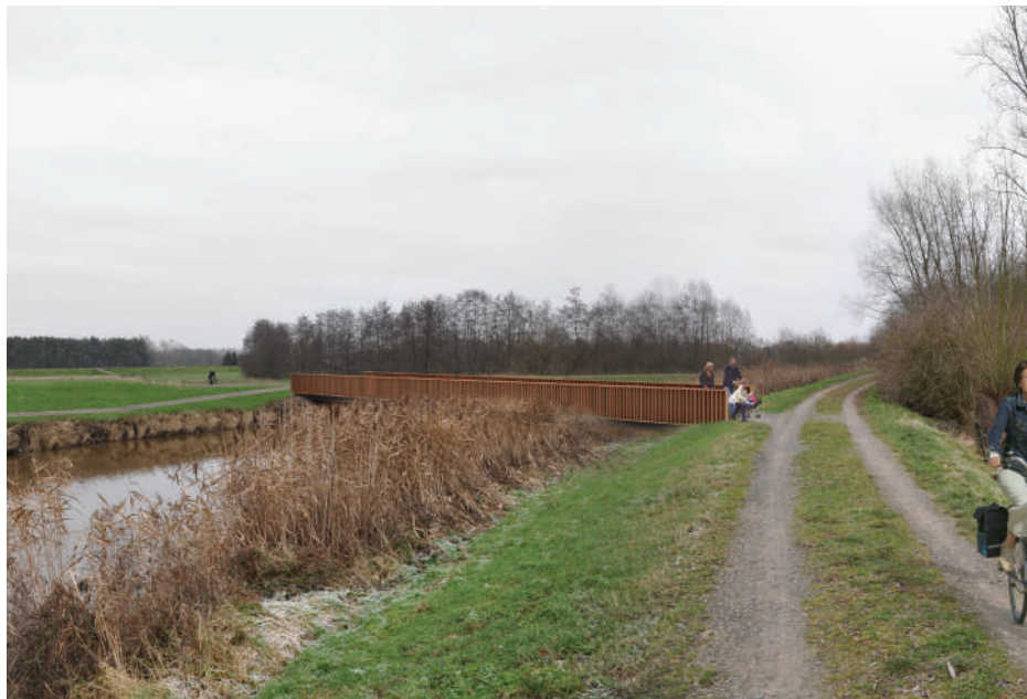
Een fietstocht of wandeling van Hever naar Rijmenam zal in de toekomst via een nieuwe brug over de Dijle en de dijkoversteek in de verte kunnen gebeuren. De borstwering bestaat uit een houten kader met verticale spijlen.
