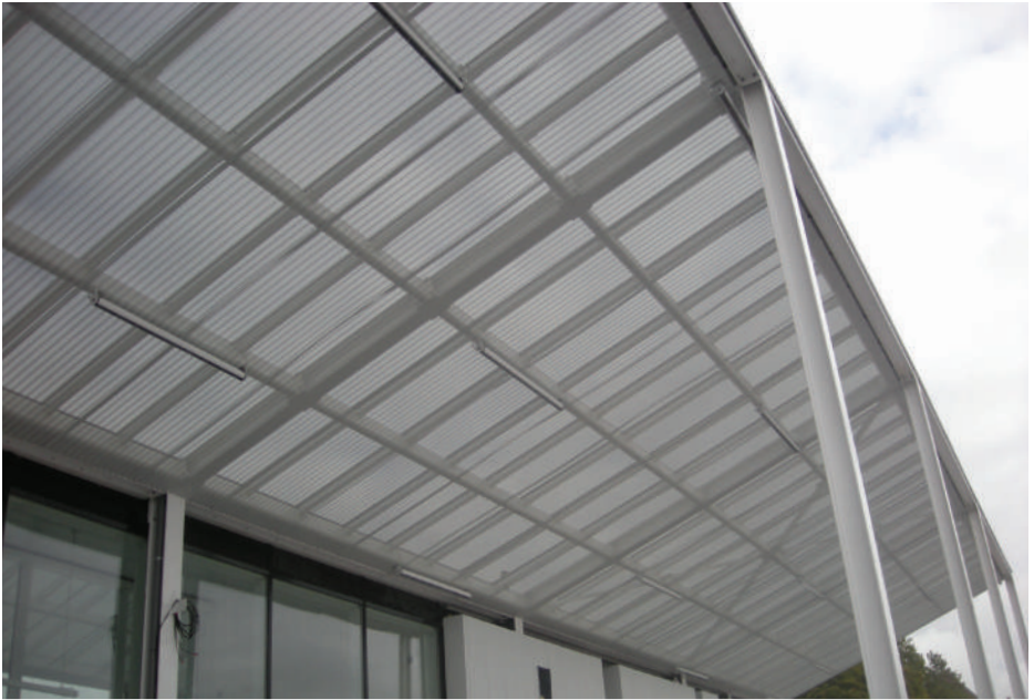
Geperforeerde staalplaten zorgen voor diffuus licht
