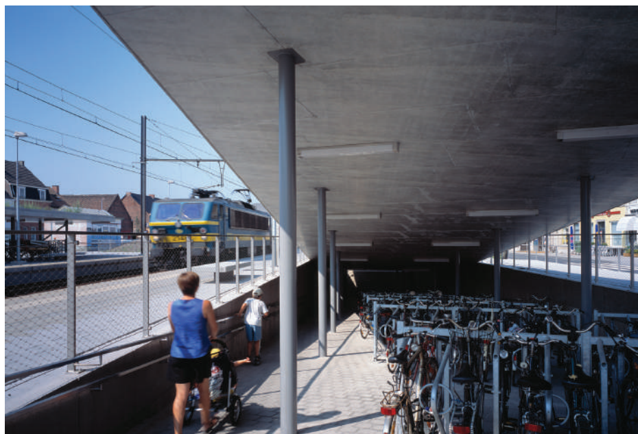
Fietsenstalling in combinatie met spooronderdoorgang | foto Kristien Daem
