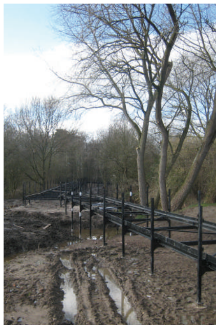
Plaatsing van de stalen portieken | 2 februari 2014
