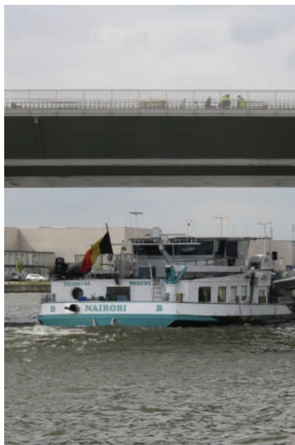
Stalen kokerbrug met inox valbescherming | 26 april 2010
