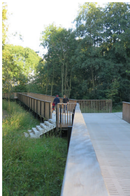
Aansluiting trap op passerelle | 25 september 2014
