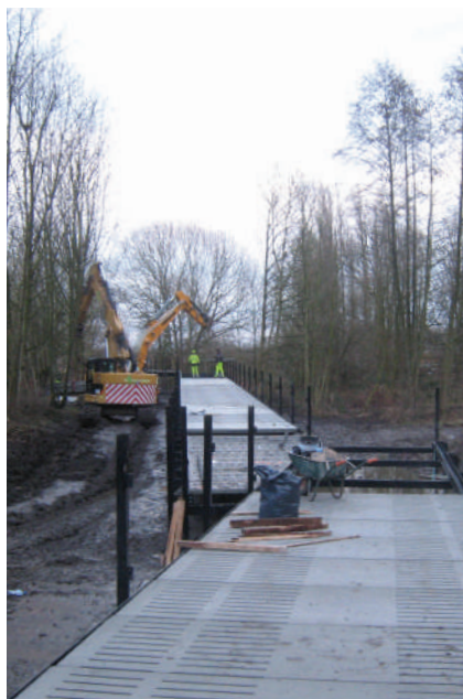
Plaatsing van betonnen prefabroosters | 5 februari 2014
