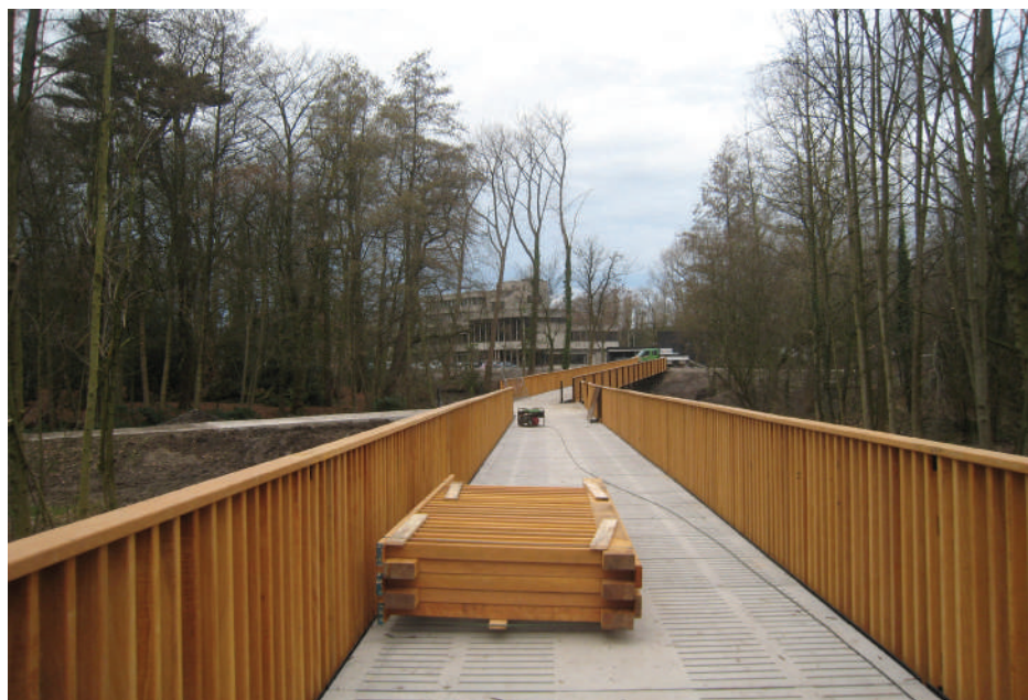
Plaatsing van houten spijlenbalustrade | 25 februari 2014
