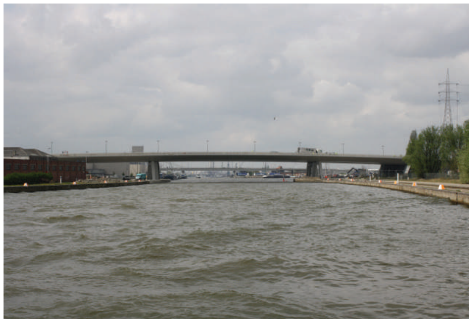
Noorderlaanbrug over het Albertkanaal | 26 april 2010
