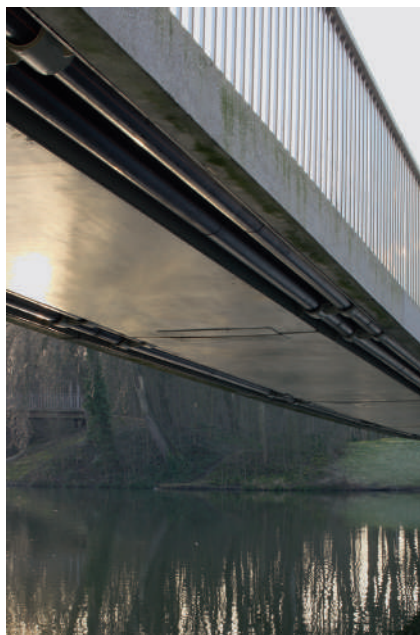
Onderzijde van de brug | foto Jan Kempnaers
