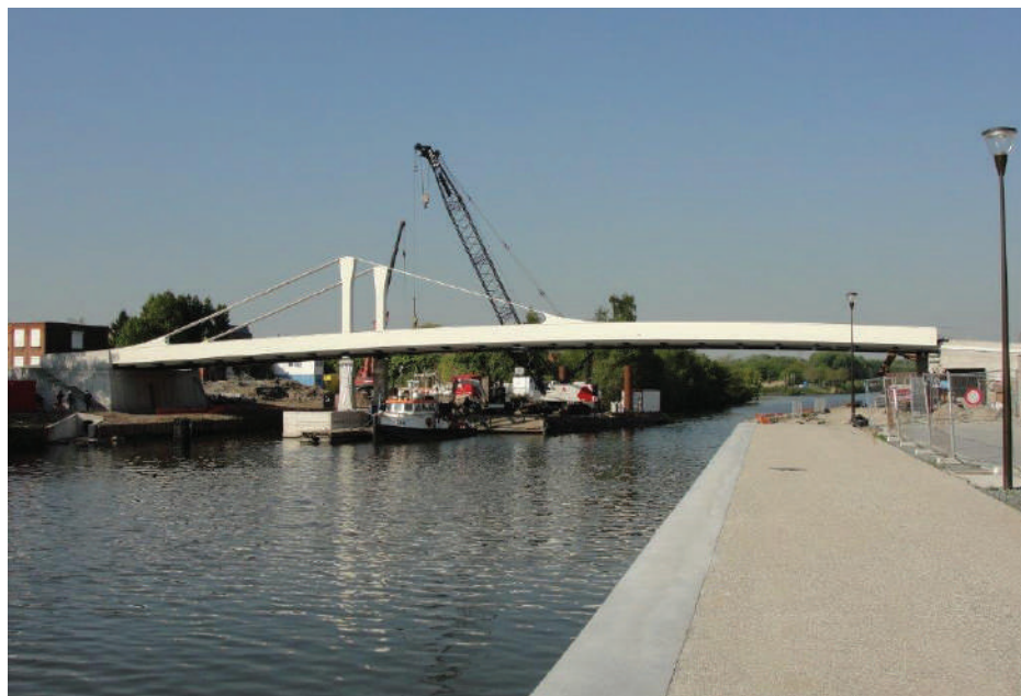
Plaatsing van de brug | 10 mei 2017
