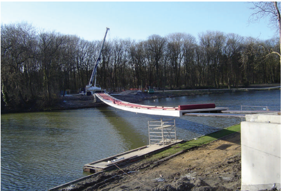
Constructie brug | 5 april 2006
