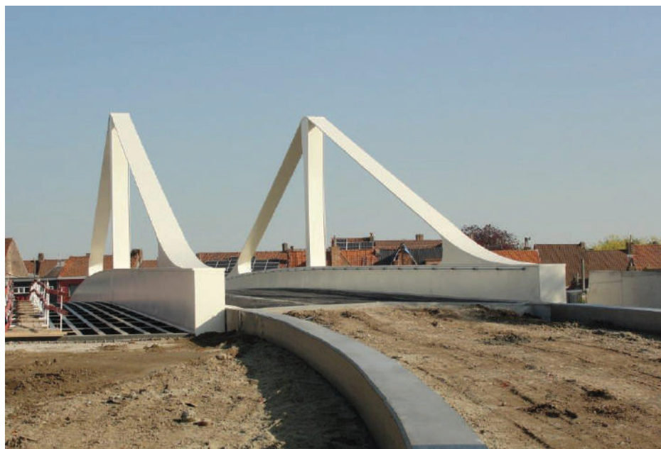
Plaatsing van de brug | 10 mei 2017
