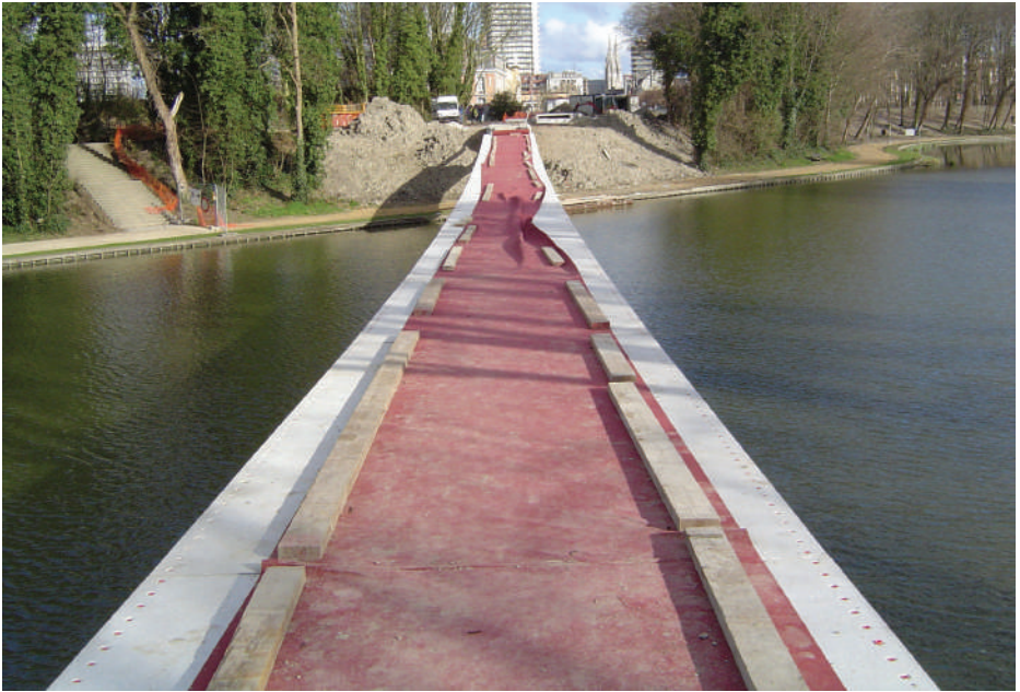
Constructie brug | 5 april 2006
